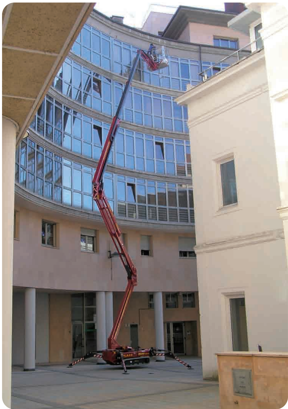
Plataforma modelo oruga 23 metros en la Sede del Colegio de Arquitectos.
