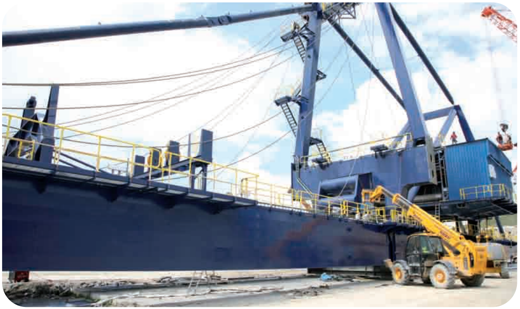
JCB 535-12 en la obra del Puerto Exterior del Ferrol.
