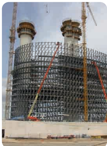
Plataformas telescópicas en la Expo de Zaragoza en la Torre del Agua.
